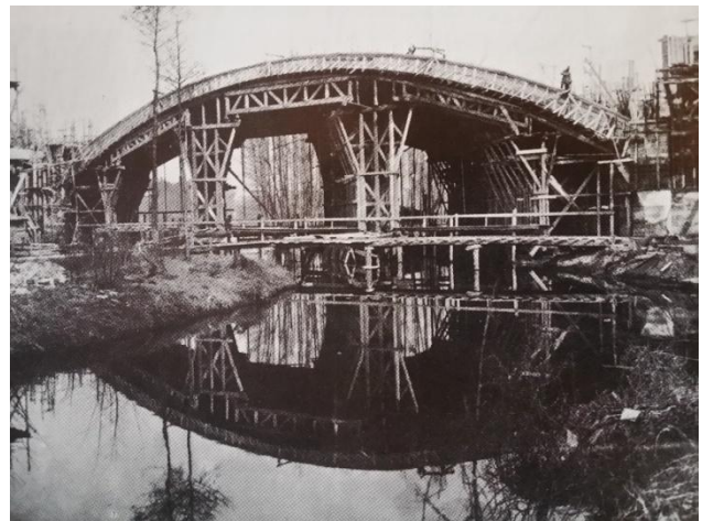
Rullatura con un mezzo a vapore e costruzione di un ponte in cemento sull'Olon. L'autostrada venne realizzata in 500 giorni, cioè un chilometro ogni 13 giorni! Costò 90 milioni, tutti a carico dell'impresa dell'ingegnere, che si rifece con il pedaggio riscosso in 17 caselli.
