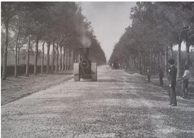
Rullatura con un mezzo a vapore e costruzione di un ponte in cemento sull'Olon. L'autostrada venne realizzata in 500 giorni, cioè un chilometro ogni 13 giorni! Costò 90 milioni, tutti a carico dell'impresa dell'ingegnere, che si rifece con il pedaggio riscosso in 17 caselli.
