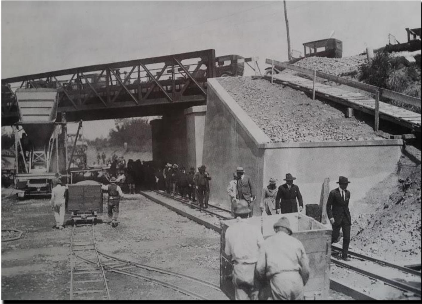
Realizzazione di un sovrappasso dell'autostrada mediante un ponte a struttura metallica. Questa tipologia costruttiva rimase in uso per molti decenni e a volte è usata tutt'oggi per interventi d'emergenza.
